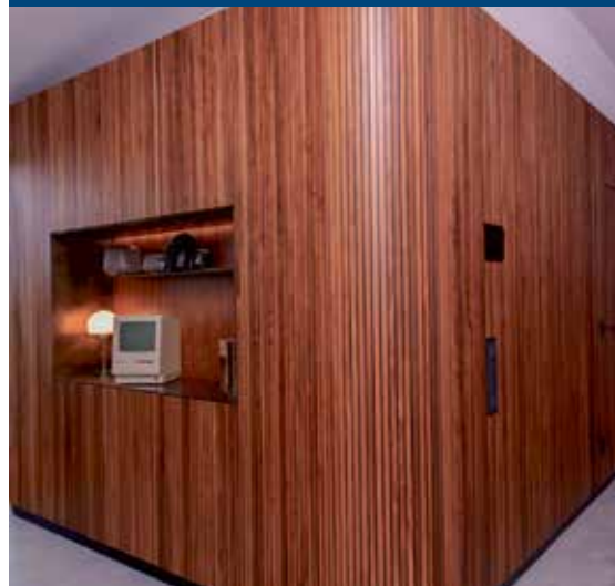
Wandverkleidung mit integriertem Einbauschränk
